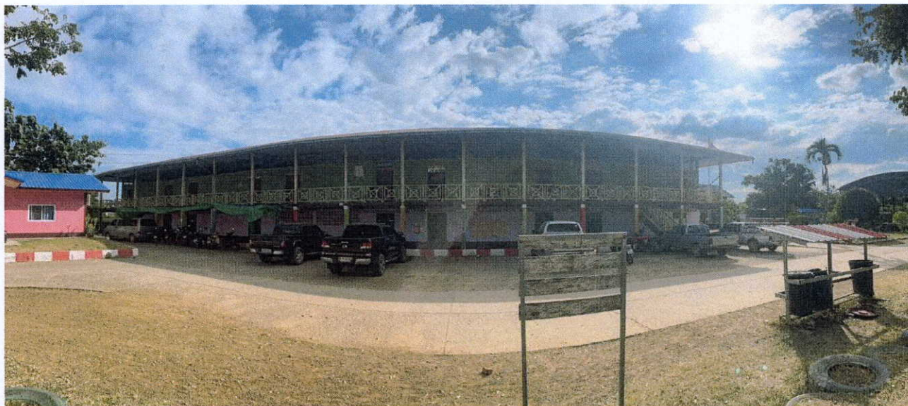
ภาพถ่ายอาคารเรียน ป.1 ซ.8 ห้องเรียน
