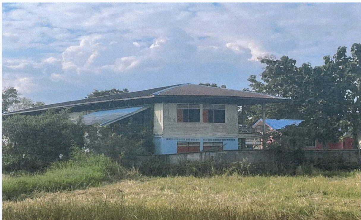
ภาพถ่ายอาคารเรียน ป.1 ซ.8 ห้องเรียน
