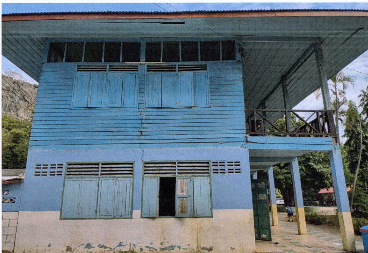
ภาพถ่ายอาคารเรียน ป.1 ซ.4 ห้องเรียน
