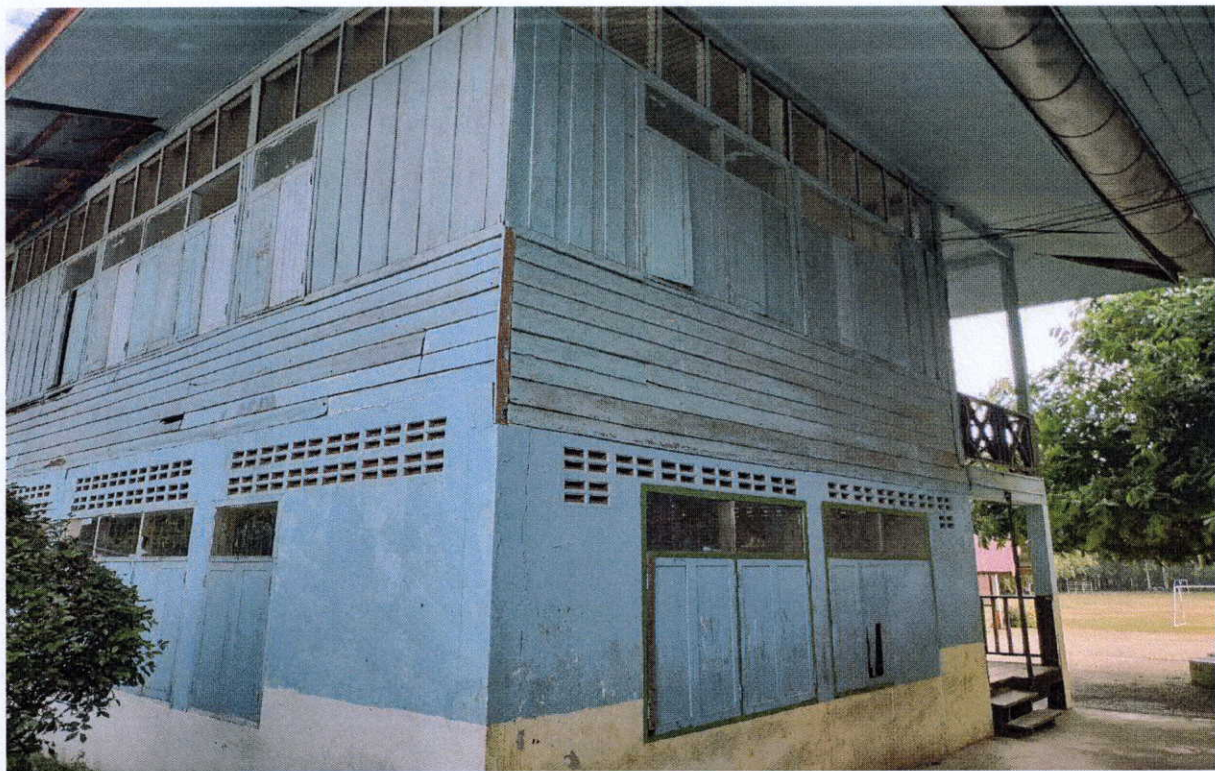
ภาพถ่ายอาคารเรียน ป.1 ซ.6 ห้องเรียน
