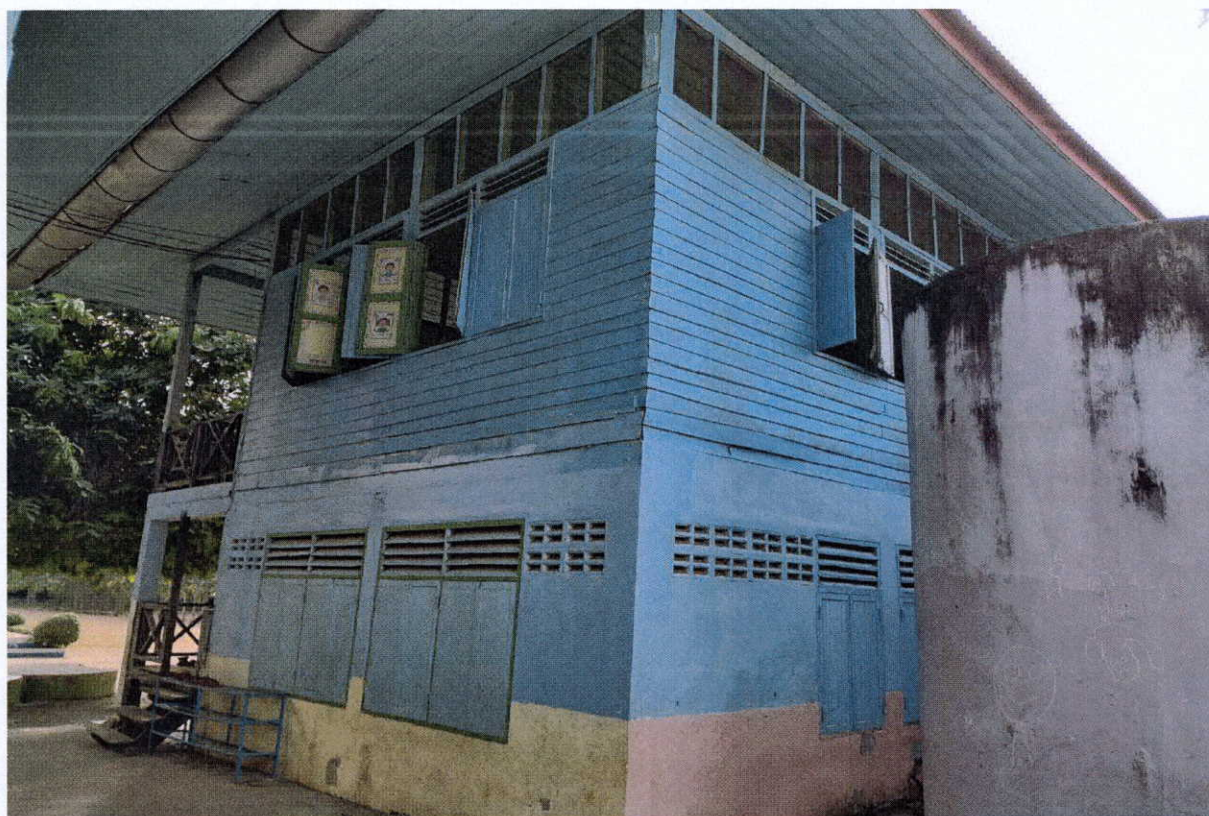
ภาพถ่ายอาคารเรียน ป.1 ซ.4 ห้องเรียน
