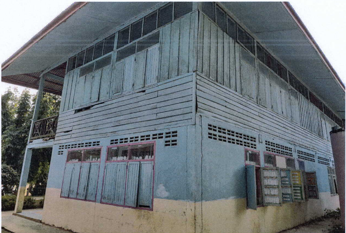
ภาพถ่ายอาคารเรียน ป.1 ซ.6 ห้องเรียน
